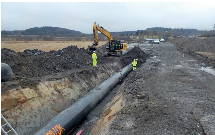
Ny hovedvannledning i Stokke
