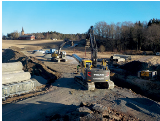
Alle premorør er skiftet ut med stålrør
