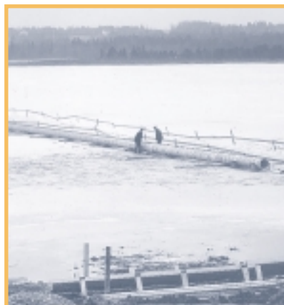
Jobb med sugeledningen som tar vann fra Akersvann og inn til vannverket.
