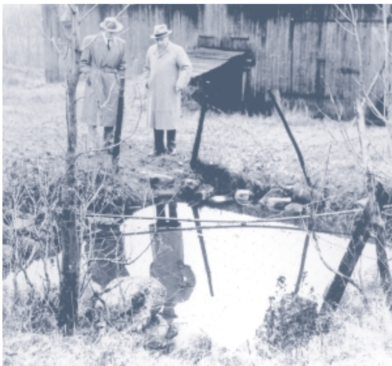
Brønnbefaring med Lensmann Flåtten i Ramnes.
